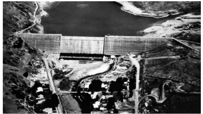
Fig. 1.2—Willow Creek Dam, OR. (USACE 1984).
