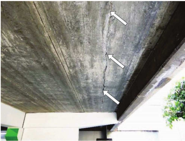
Fig. 4.1.2.4—Longitudinal crack.
