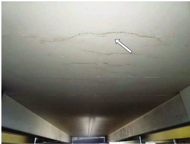
Fig. 4.1.2.11—Transverse crack.
