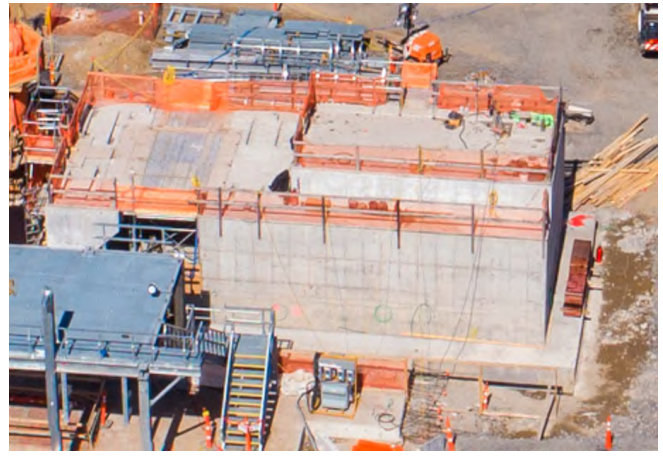
(d) Bracket concrete placed
