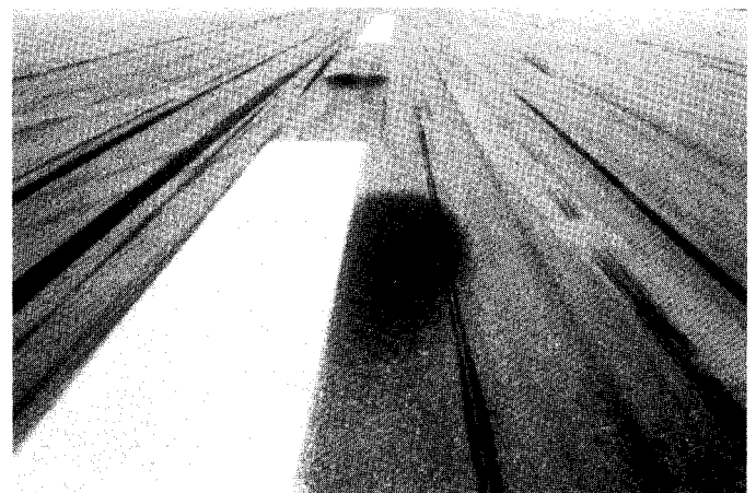
FIG. X1.28 Jet-Blast Erosion
