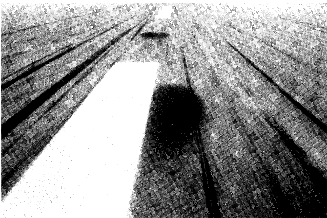
FIG. X1.28 Jet-Blast Erosion
