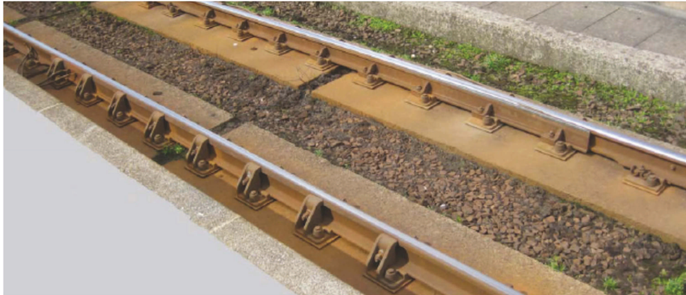
Bild 15 — Schienenauszug bei Fester Fahrbahn
