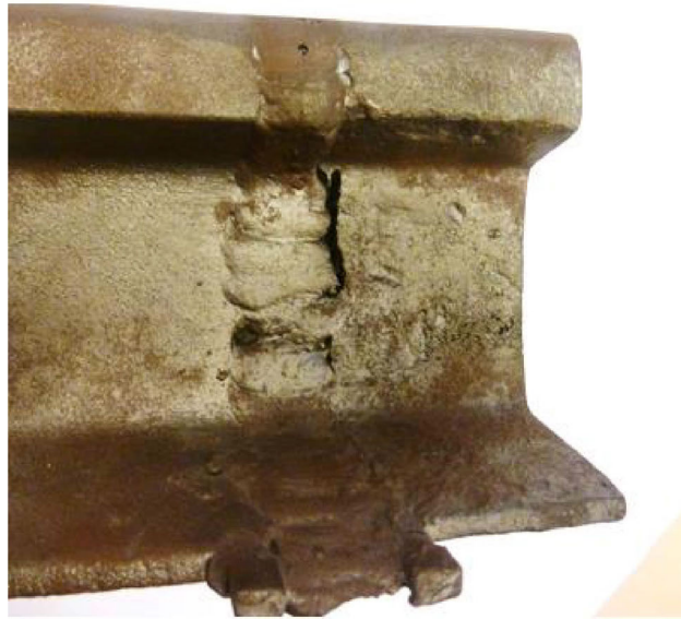
Bild A.7 — 431 – Querriss im Profil der Lichtbogenschweißnaht
