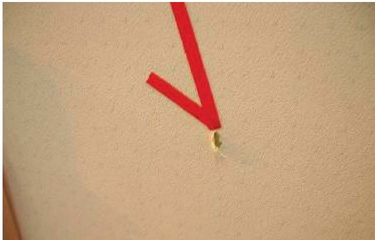
Bild A.1 — Beispiel einer Perforation
