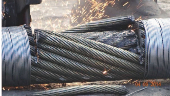
Bild 3 — Alternative Abbinde- und Trennmethoden für drehungsarme Seile mit großem Durchmesser
