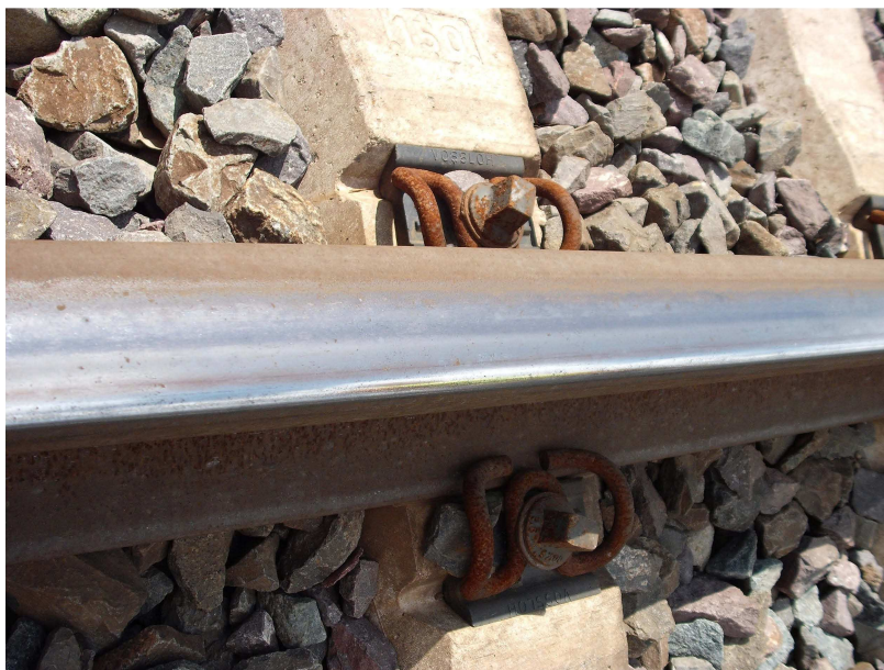
Bild 6 — Abgeflachtes Querprofil
