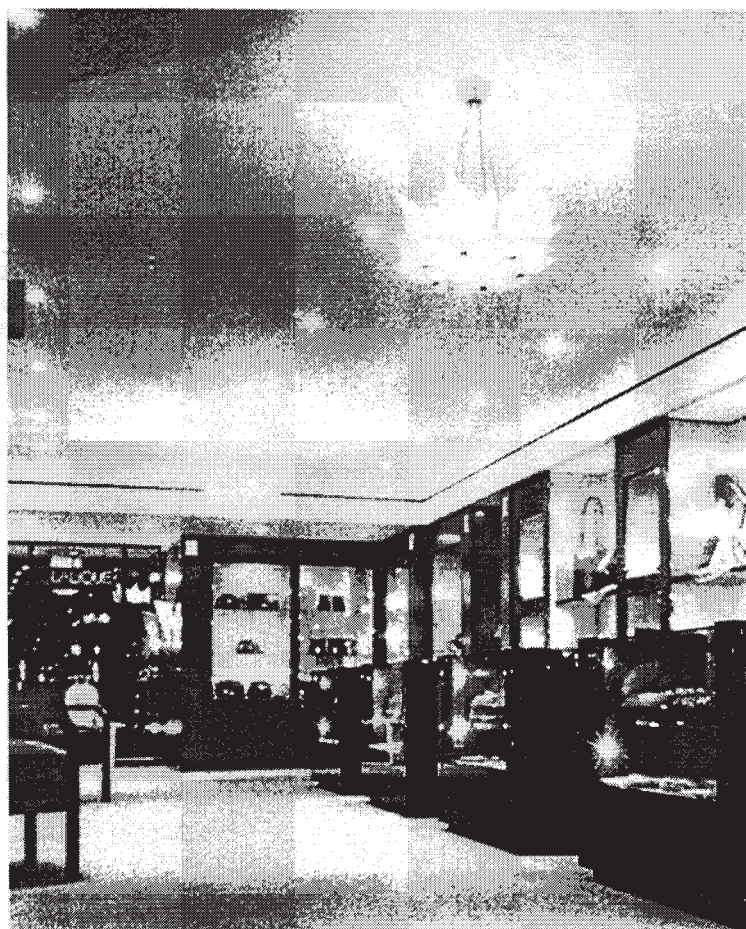
Bild 4: Faserverstärkte plattenförmige Gipsteile (z. B. Plattendecke in einem Geschäft)
