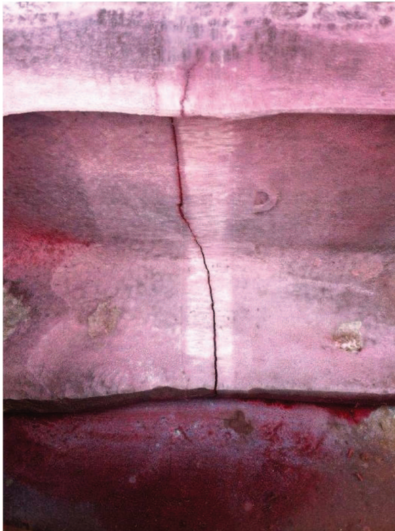
Bild 7 — Querschweißungsfehler in der Trimetallzone (b)
