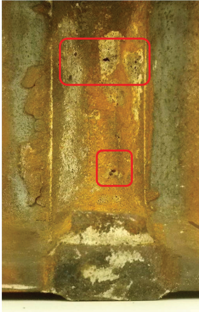
Bild 14 — Oberflächenfehler an der Schweißwulst
