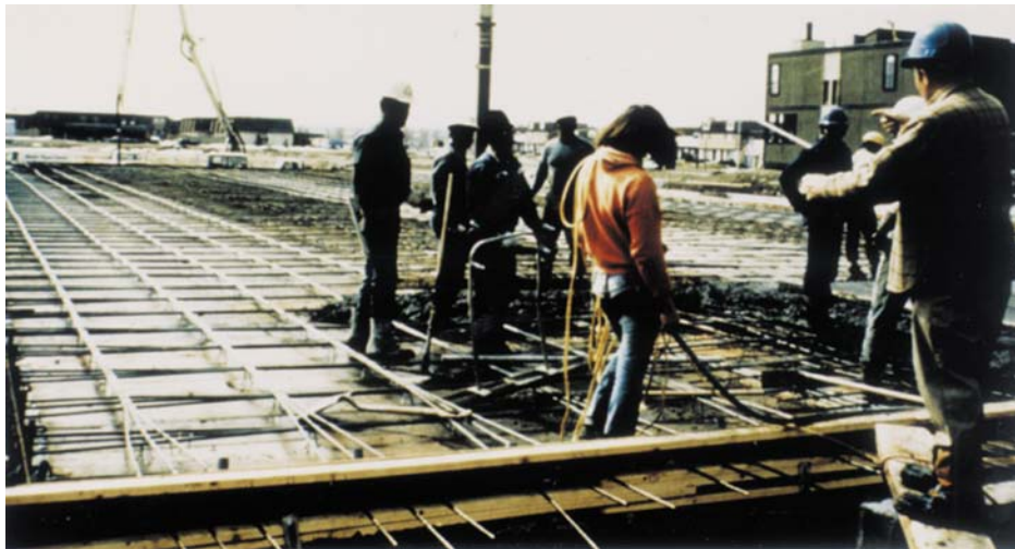
Fig. 2-9 Colocación del concreto
