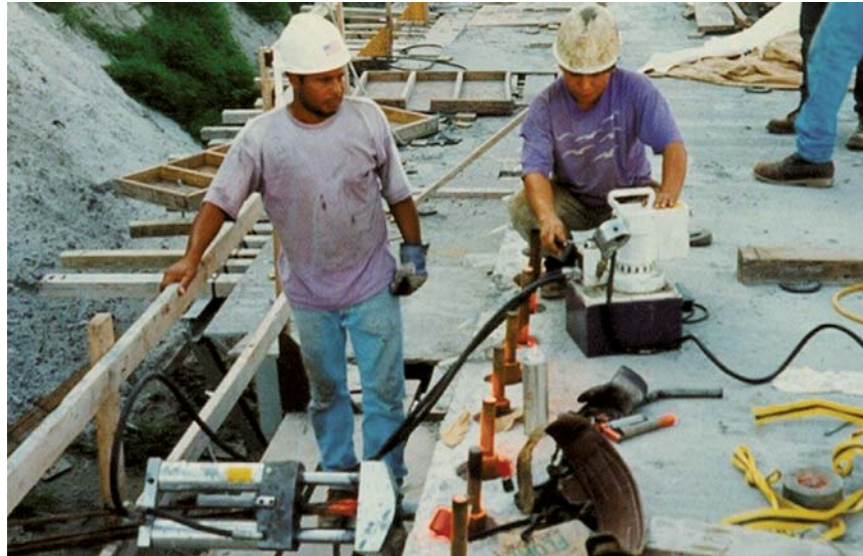
Fig. 2-10 Tensionado de tendone
