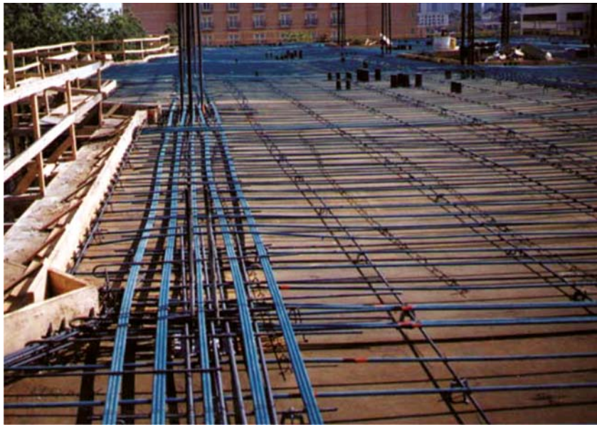
Fig. 2-8 Disposición de tendones agrupados y distribuidos en la plataforma
