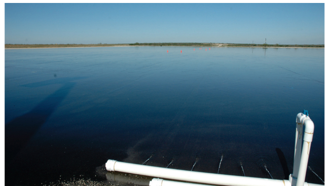
Figure 6. Uvalde 250 × 250 meter Wet Pad
