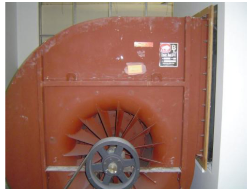
Figure 3. Double Impeller Centrifugal Fan
