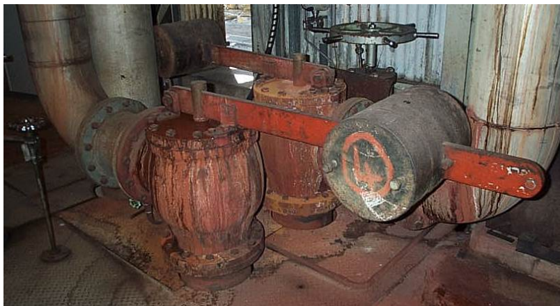
Fig. 4. Lever valvetype.
